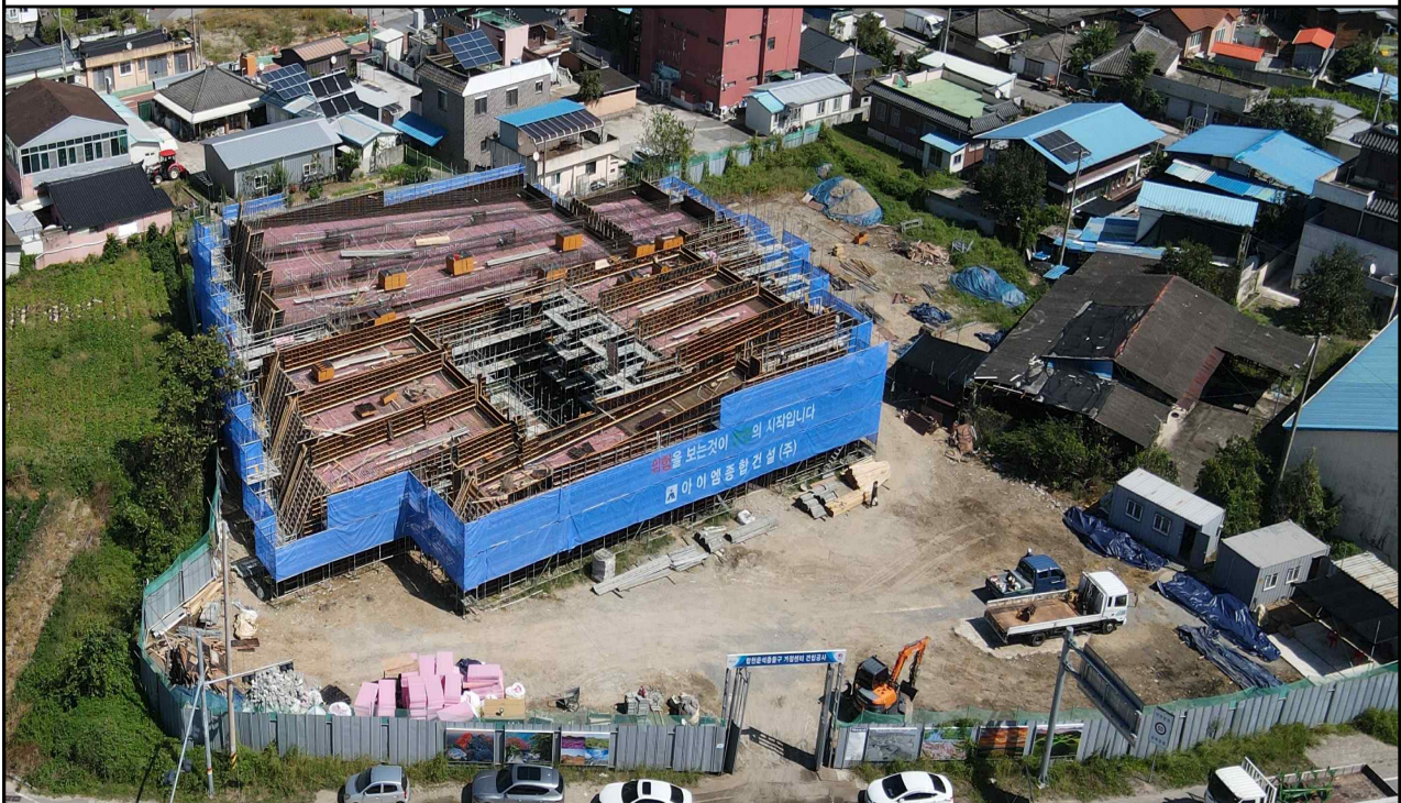
합천운석충돌구 거점센터 건립 공사현장
